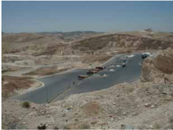
アルシャール中継基地(1) 2003 年稼動開始の最新中継基地全景
