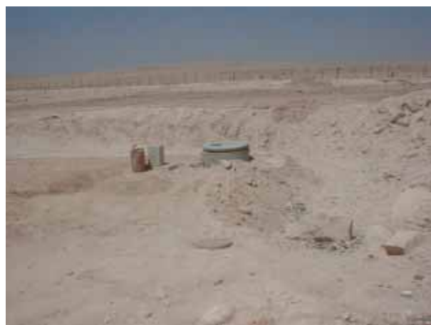
マドナーガバウイ最終処分場(4) 浸出水処理施設建設予定地 (ポンプピットは完成)
