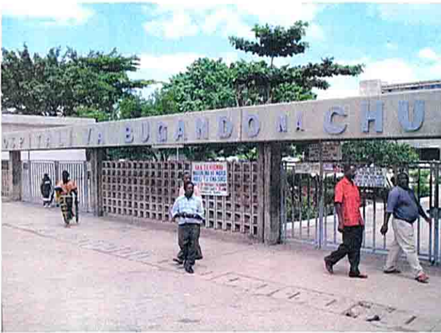
ブガンド病院の外観 最高技術を有し、管轄下の州や県の病院に対して指導的役割を果たすリファラル病院と位置付けられている
