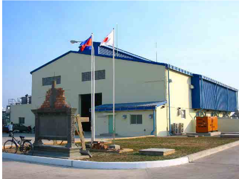
ディーゼル発電所建屋の外観
