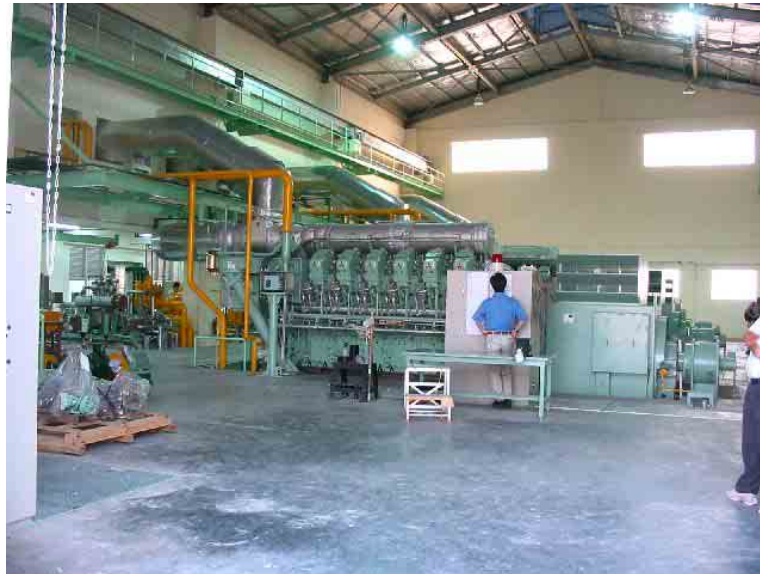
イ 建屋の中。稼働中の三菱重工製ディーゼル発電機
