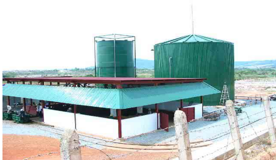
バイオガス発生装置
