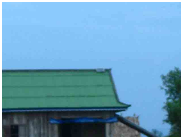
PV パネル(12W)
