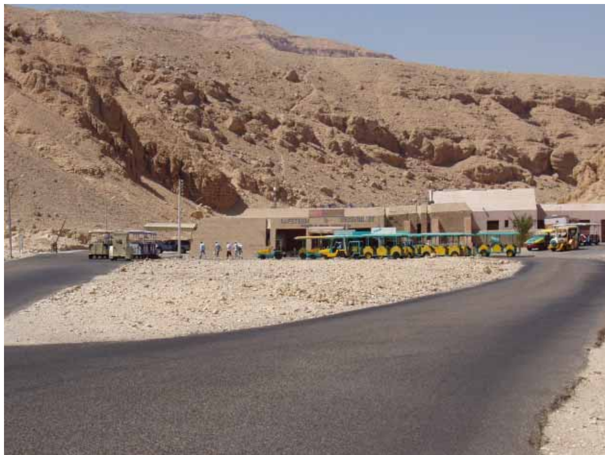
サイト(南側より)と既存カフェテリア (上図 1 より)
