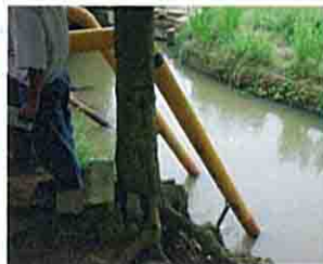
灌漑用水からの取水管
