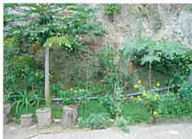
剥き出しの給水管
