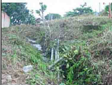
給水管に穴を開けた空気弁の代用
