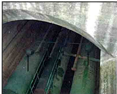
放流管に取り付けられた飲料水 取水のための分岐口
