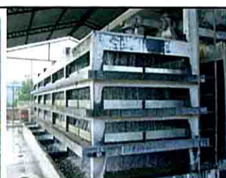
カランキ浄水場の曝気装置 (上) カランキ浄水場全景 (左)
