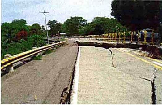
**写真 13：車道の陥没現場（1）**
