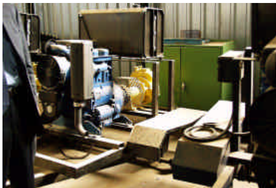
写真 5：ハフォソ中央倉庫の灌漑ポンプ
