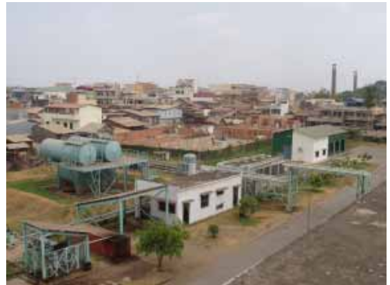
既存廃油処理装置
