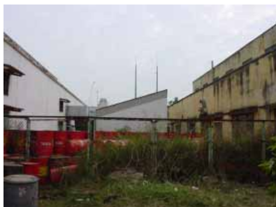
1および2号発電設備用の換気設備建屋 既存は別棟で、ダクト方式を採用している。手前のドラム缶が本計画用の予定用地となっている。
