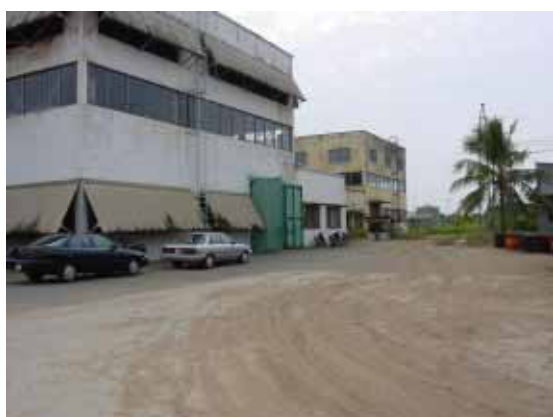
C5 およびC4 発電建屋 手前が C5 発電建屋。本計画で建設する発電設備は緑色の両開き扉から搬入予定である。奥が C4 発電所。
