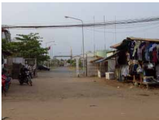
発電所入り口
