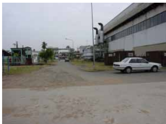
既存発電設備と構内道路 構内道路と発電建屋の空地にラジエーター等の新設の屋外補機を設置する
