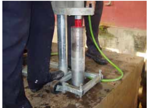
コンクリートコア抜き試験
