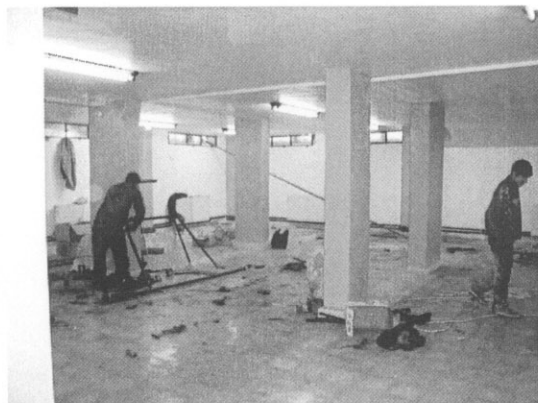
地下室。研修室及び資料室として工事中
