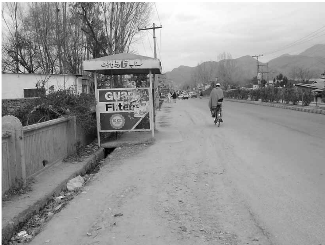
送水管敷設ルート(カラコルム・ハイウェイ)
