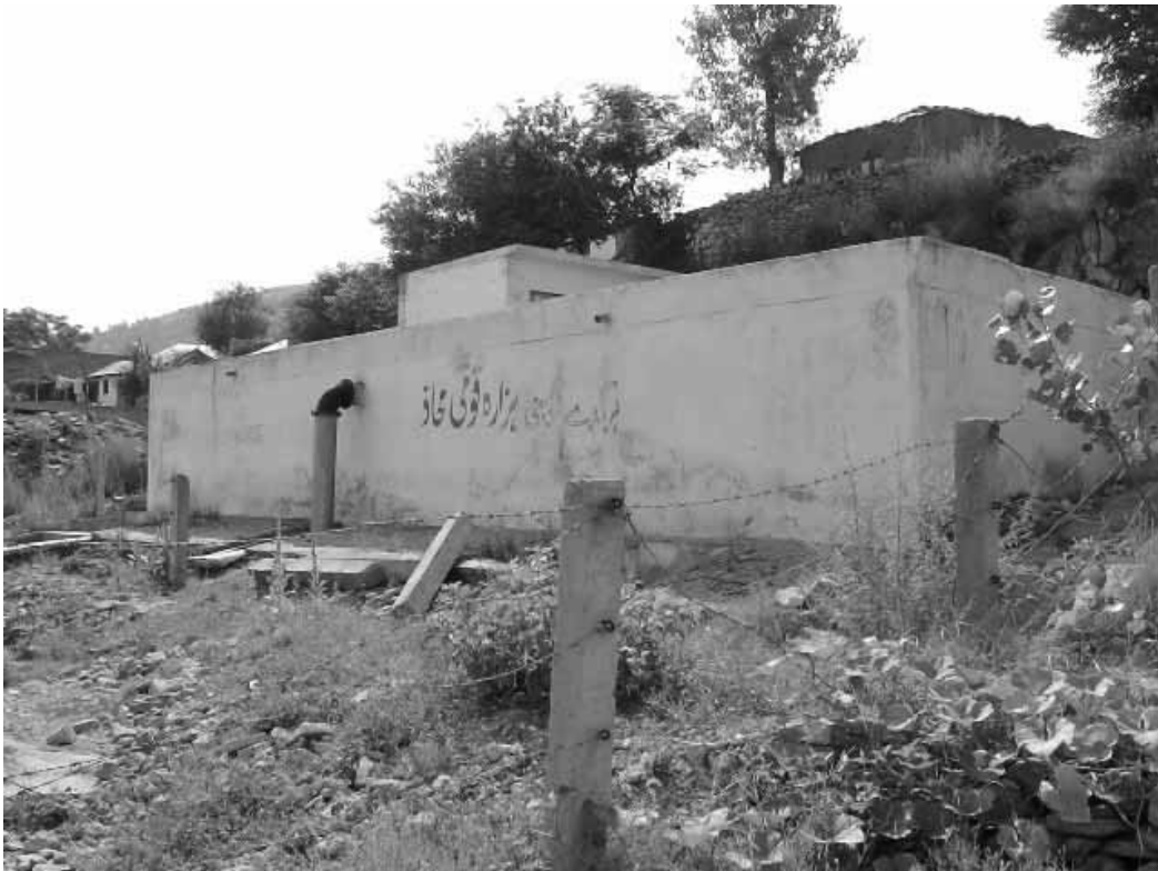
アボタバット市の Khola Kehal 配水池(100,000 GLS)
