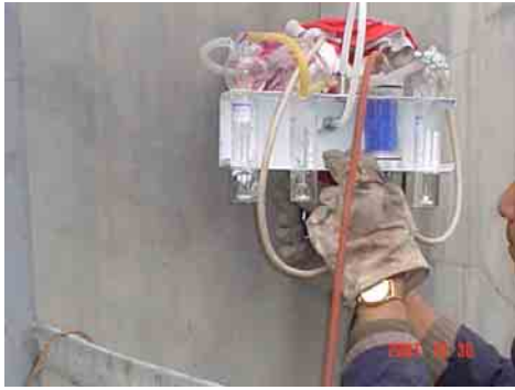
贵阳水泥厂 (SO 2 采样近景-1)
