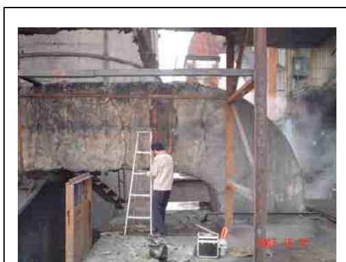
贵州水晶化工 (1-3号炉采样孔在屋顶)
