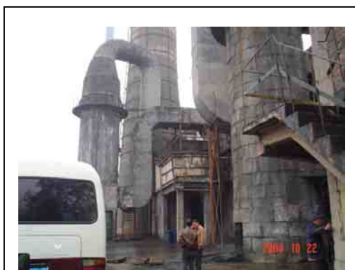
贵州水晶化工 (水膜除尘)
