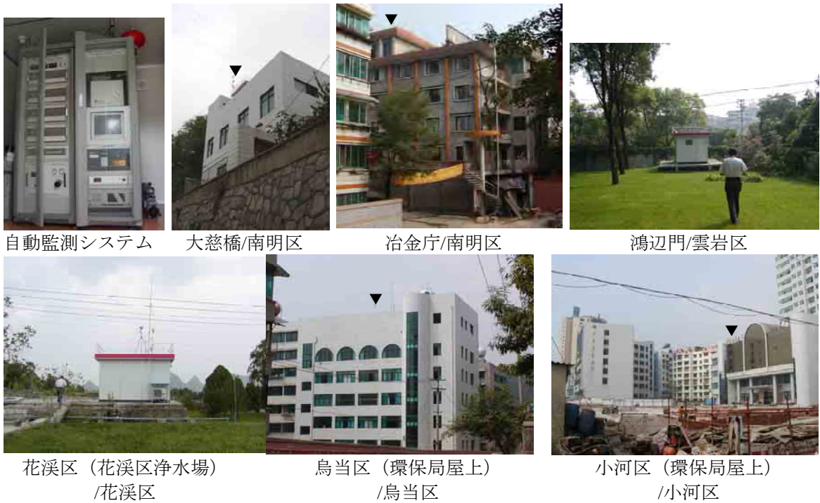
図 1.1-3 新規監視局の状況
