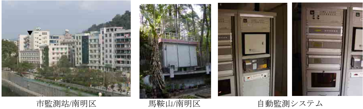
図 1.1-2 既存監視局の状況
