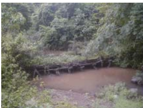
写真 8.5 木組みの取り入れ堰
