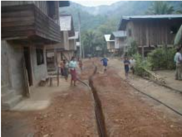
写真 4.1 給水施設 (パイプライン埋設) 工事
