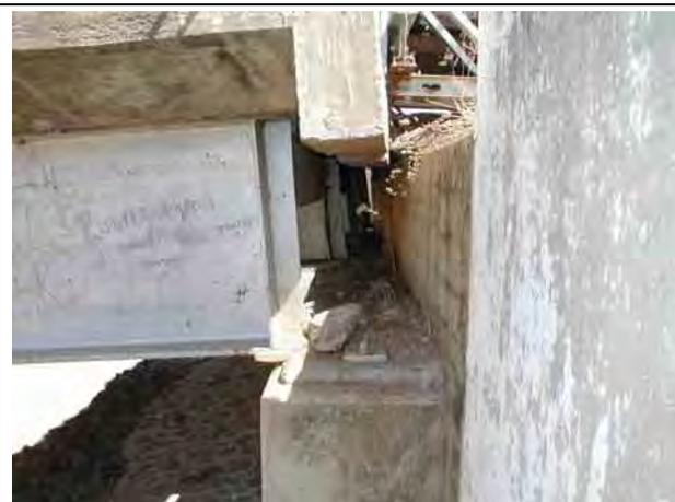
写真4-5 橋脚の沈下により移動した上部構造
