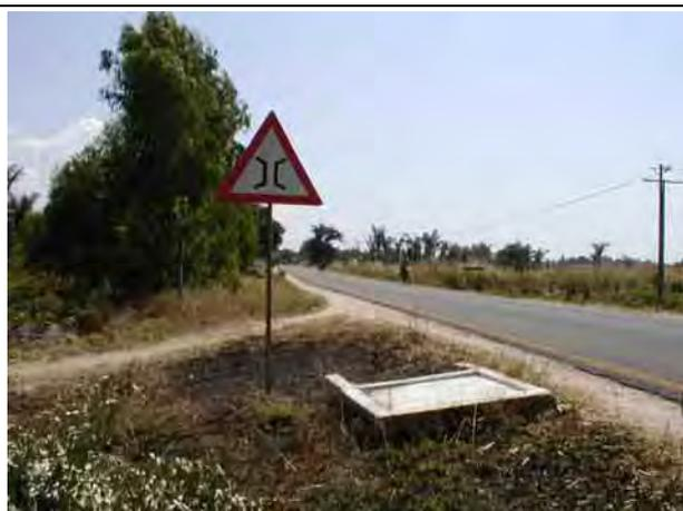
写真 7-6 車輛の衝突により転倒した安全標識
