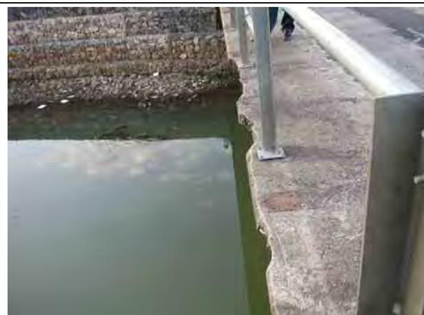
写真 5-5 コンクリート床版の欠け
