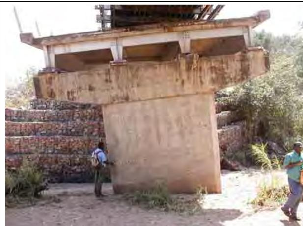
写真4-3 洗掘により沈下した北側橋脚
