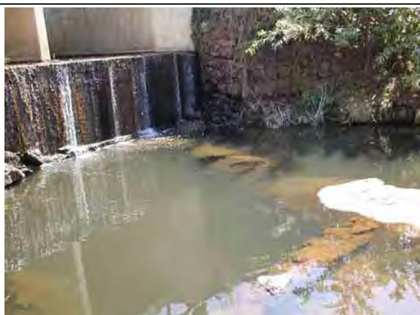
写真 10-4 洗掘により損傷したエプロン
