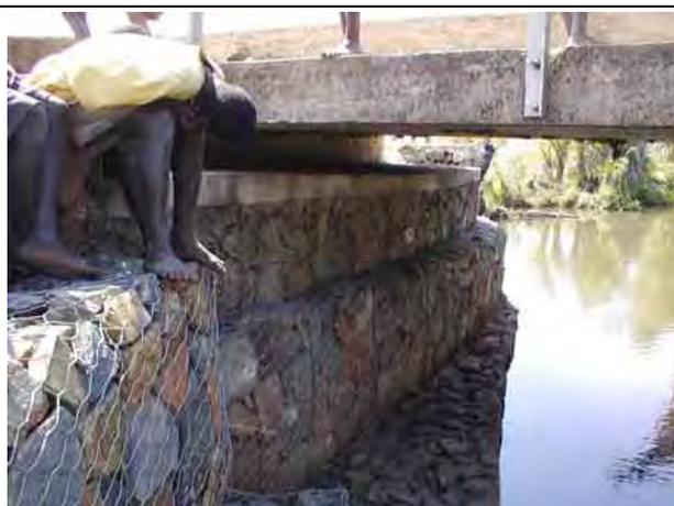
写真 7-4 蛇かごにより補修された北側橋台
