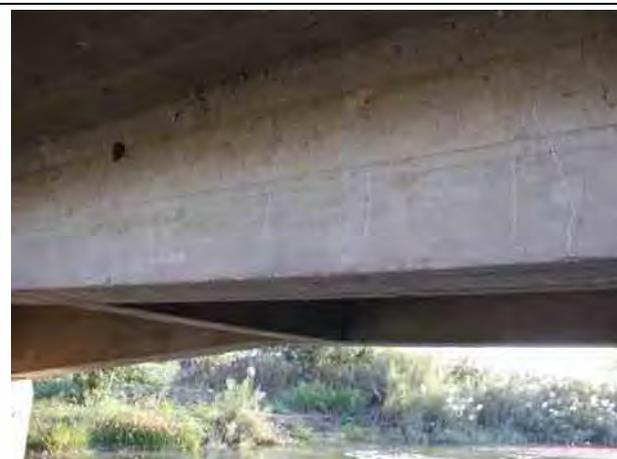
写真 5-3 主桁のコンクリートひびわれ
