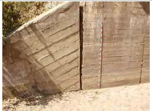
写真 2-4 下流部の翼壁の沈下
