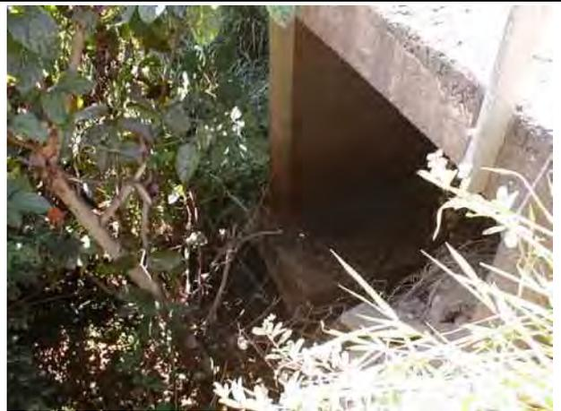
写真 9-4 洗掘により露出した南側橋脚の基礎
