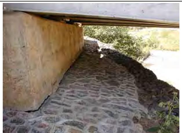
写真4-6 蛇かごの沈下による北側橋台部の隙間
