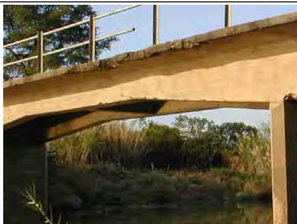
写真 5-4 主桁のひびわれ
