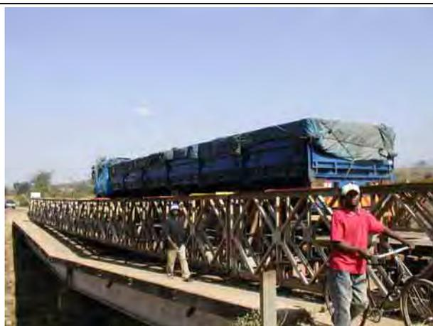
写真 3-6 仮橋を通過する重荷重トレーラー
