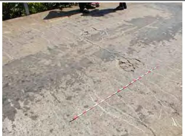
写真 9-6 コンクリート床版支点部上面のひびわれ
