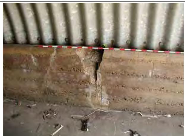
写真 1-6 コルゲートパイプ基礎の沈下とひびわれ
