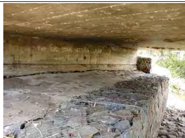
写真 7-5 蛇かごの沈下によって生じた北側橋台部の隙間
