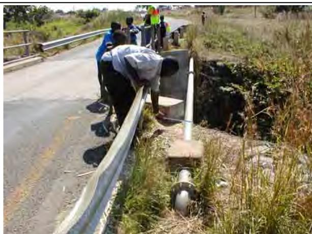
写真 10-6 下流側に添架された水道管
