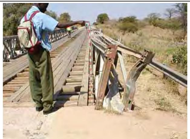
写真4-4 車輛の衝突により損傷した仮橋
