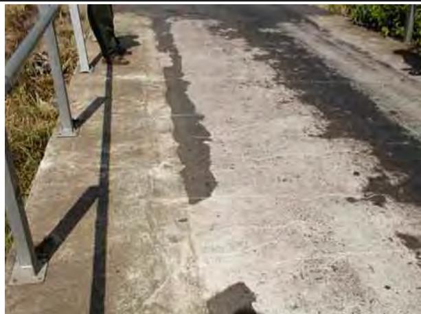
写真 6-5 支点部コンクリート床版上面のひびわれ
