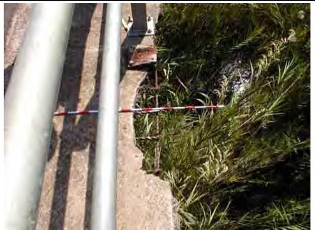
写真 6-6 コンクリート床版の欠け
