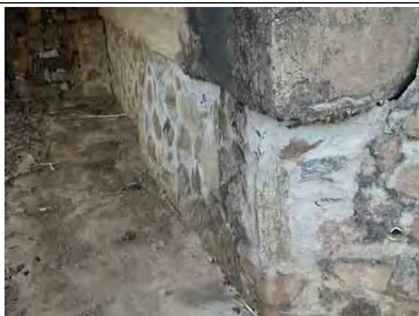
写真 5-6 練り石積みにより補修された北側橋台
