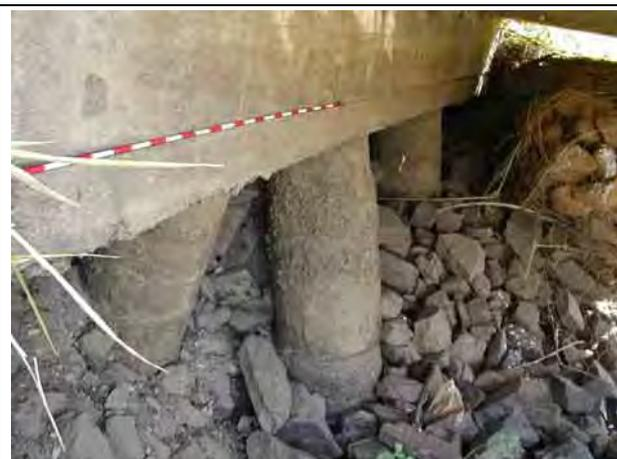
写真 8-5 洗掘により露出した南側橋台の基礎杭
