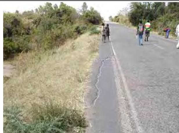
写真 2-5 下流側道路路面の沈下による舗装のひびわれ
