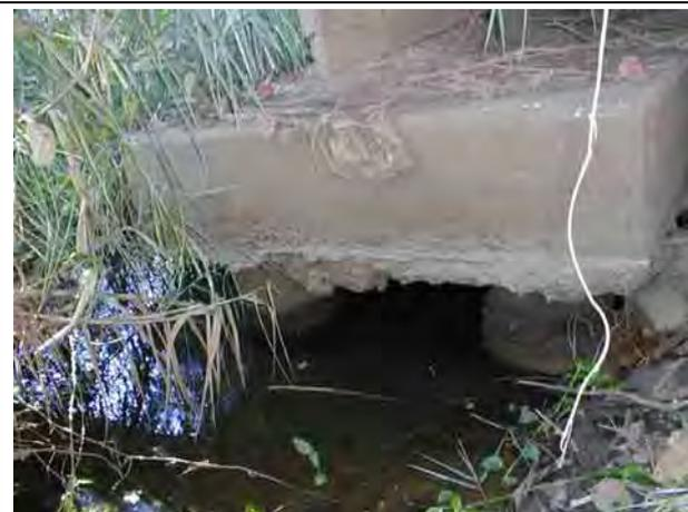
写真 9-5 洗掘により露出した南側橋脚の基礎杭
