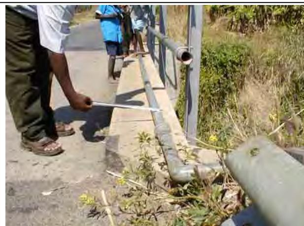
写真 10-5 上流側に添架された水道管
