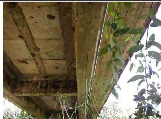
写真 9-3 健全なコンクリート床版と主桁
