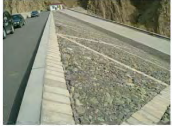
カルチダムの下流側法面
