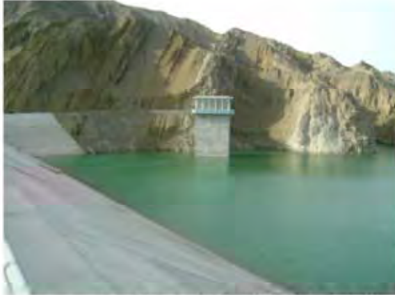
シャンシヤン県カルチダム貯水池と取水塔
