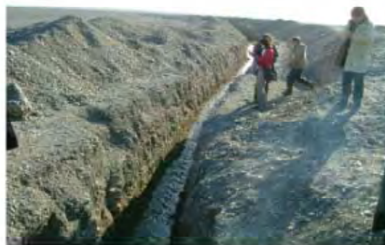
カレーズ下流側水路の状況
