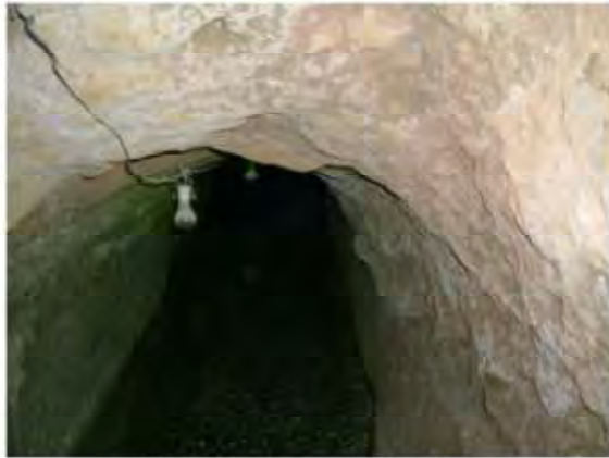
観光用カレーズ内部状況
