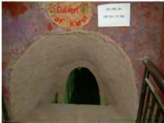
観光用カレーズ内坑壁保護状況
