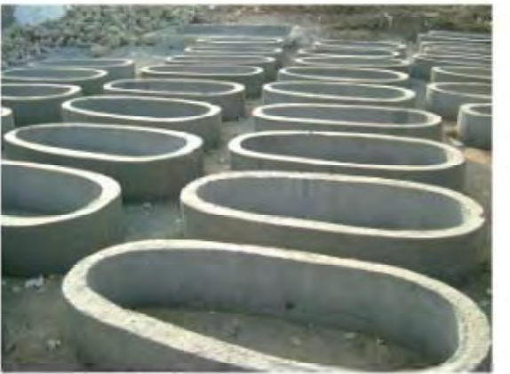
カレーズ内坑壁保護の為の既製品作成状況
