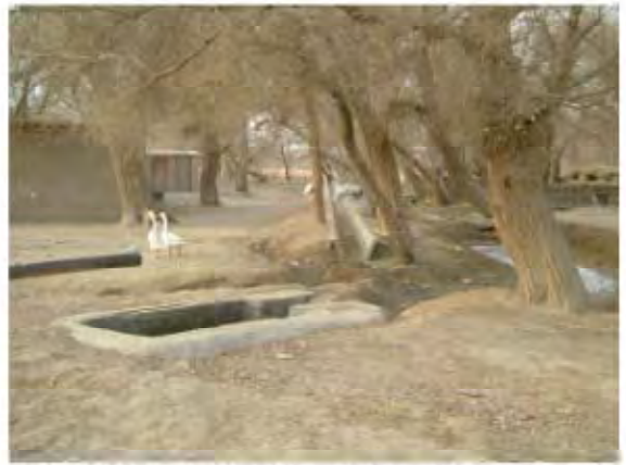
不圧層地下水揚水後の水洗い場と下流水路
