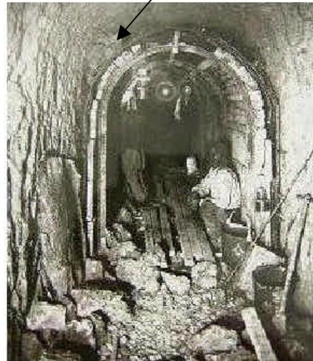
写真 - 3.5 旧トンネル 無筋区間覆工コンクリートの施工状況
