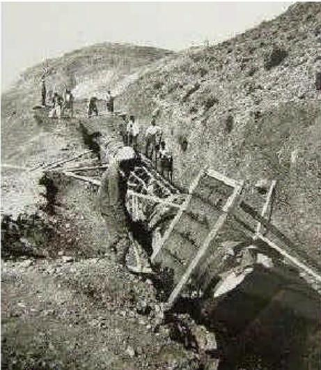
写真 - 3.4 旧トンネル 配筋区間覆工
