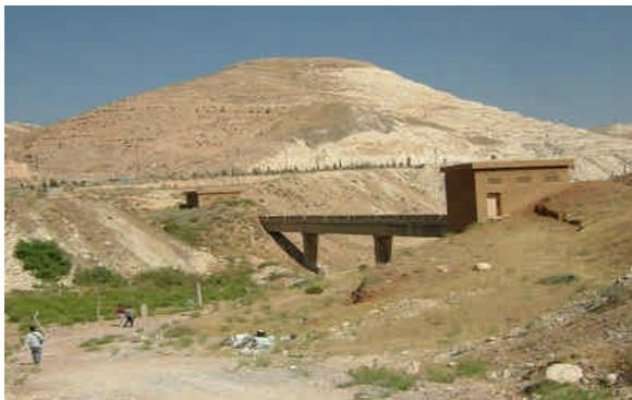
旧トンネルの水路橋 No.3。入口からの距離 (TD) 10,731? 10,794m。このような水路橋が旧トンネルには4ヶ所ある。水路橋 No.3 付近には新トンネルからの連絡管が接続しており、地中海沿岸からの送水もここにつながる予定。
