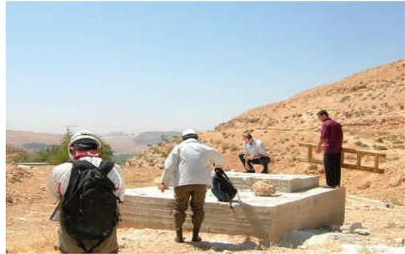
旧トンネルのゲート No.20 入口。入口からの距離 (TD) 8,380m。このように途中から出入りできるゲートが設けられている。
