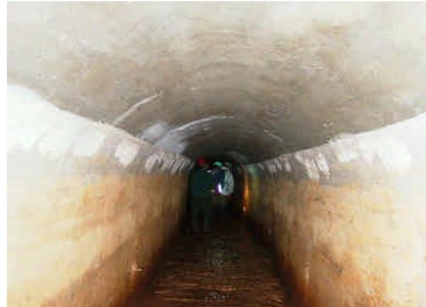
旧トンネル。1925 年から 29 年にかけて建設された延長 16km の送水トンネル。標準的な断面は幅 1.36m、高さ 1.88m。
