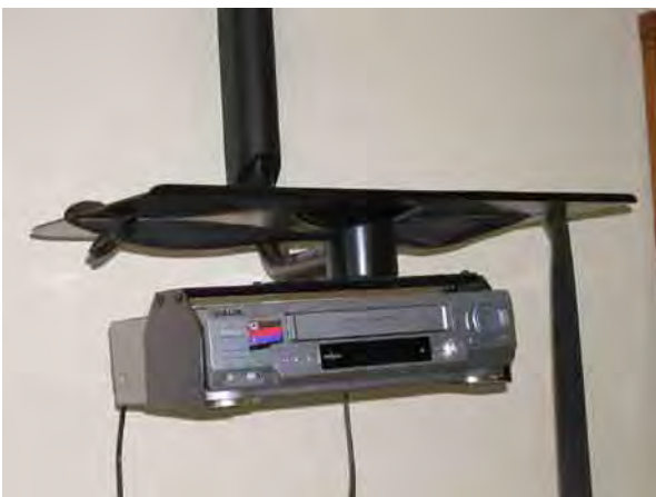
教室。天井から吊下がっている架台の上にテレビを設置。架台の下にビデオデッキが見える。
