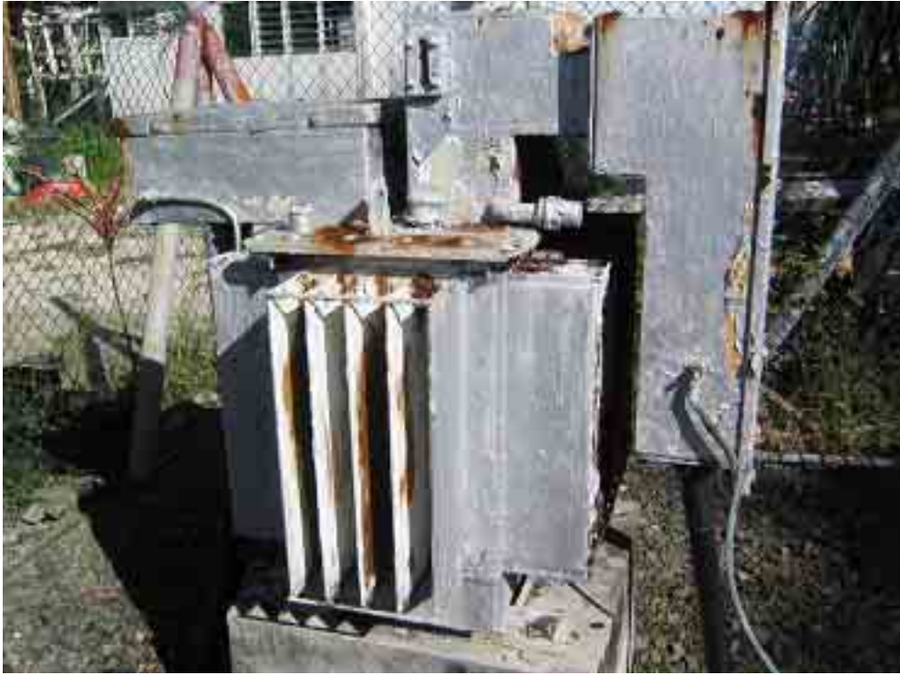
写真 5 潮風による損傷の激しい No8A 変圧器
