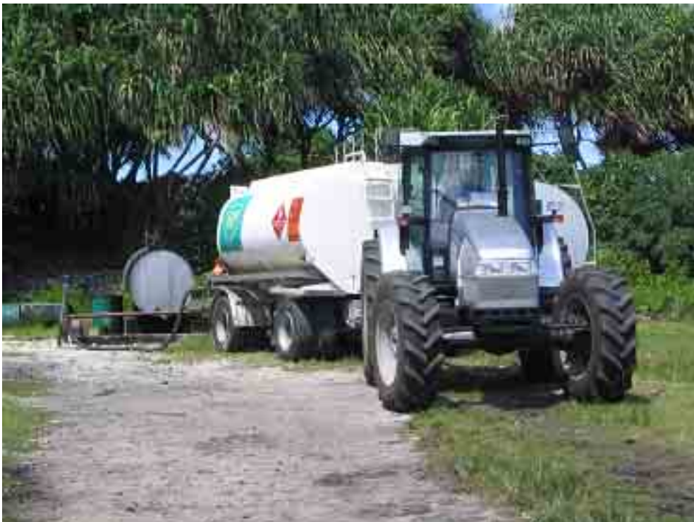
写真4 発電所の燃料受入（TEC事務所裏）
