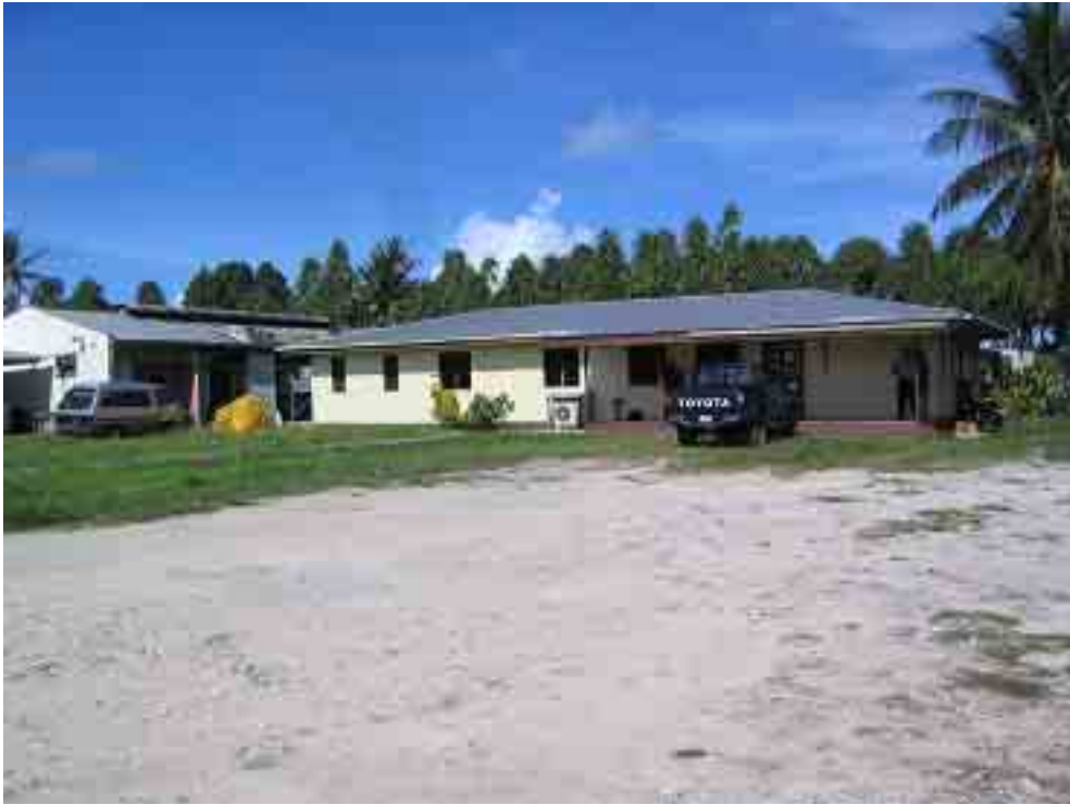
写真1 TEC 管理事務所 (滑走路側から東を望む)
