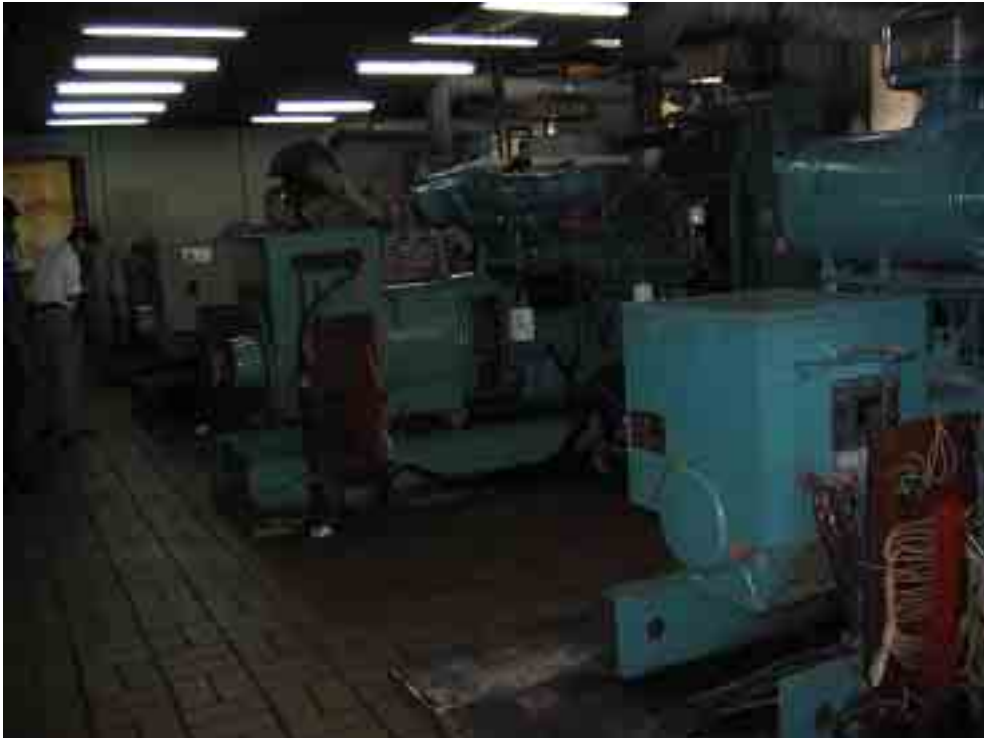
写真3 運転中の発電機（手前からNo2、No3、No4、No5）
