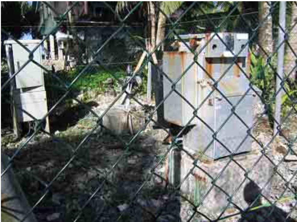
写真 6 故障により取り外された No7 変圧器と仮設ケーブル
