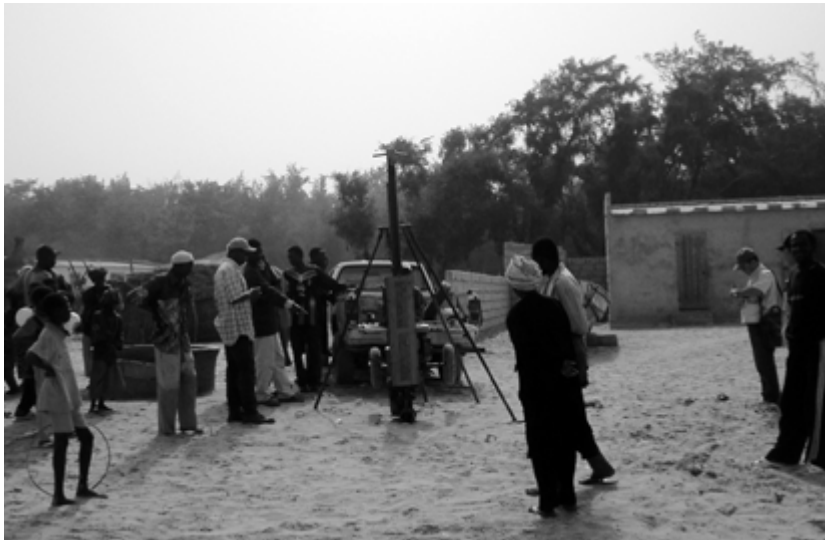
図 2-8: PD#6(南東側の既存加工場)における動的貫入試験の実施状況
