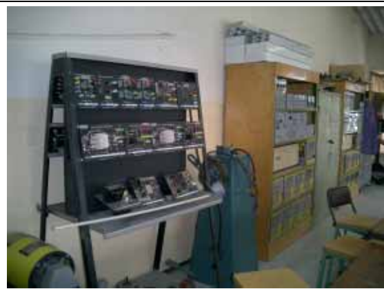
電気・電子 訓練室 (回路実習基板、電源装置等)
