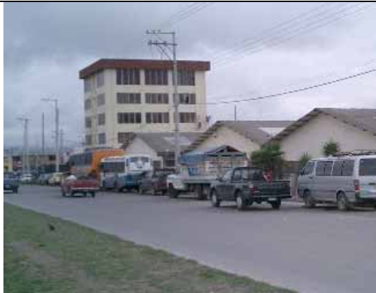
幹線道路よりCFFIA管理棟（6階建）を望む
