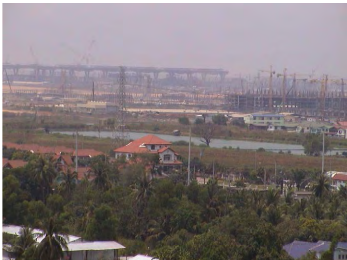
建設中の新国際空港
