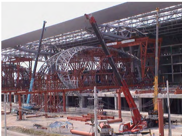
建設中のターミナルビル
