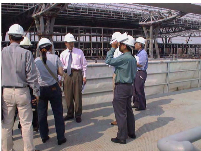
建設現場の視察
