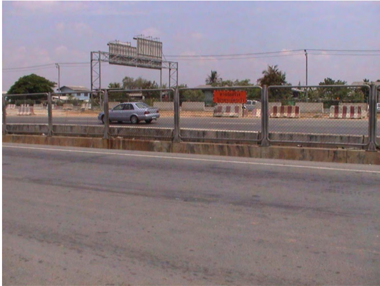
拡幅中のモーターウェイ、サイト内
