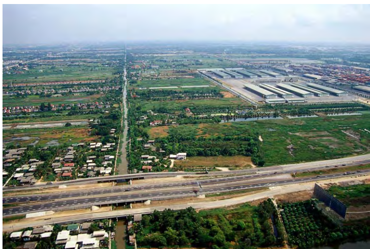
左側がサイト、右側がトラックターミナル
