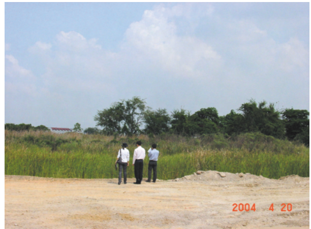
写真3-4 工事中の都市計画道路北端部分
