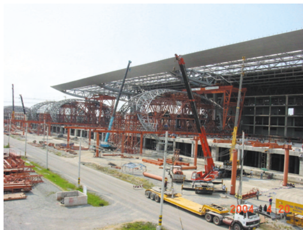
写真3-5 調査地区南隣で建設が進む空港ターミナル・ビル
