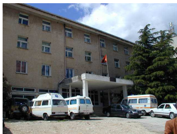
テペレネ病院外観
