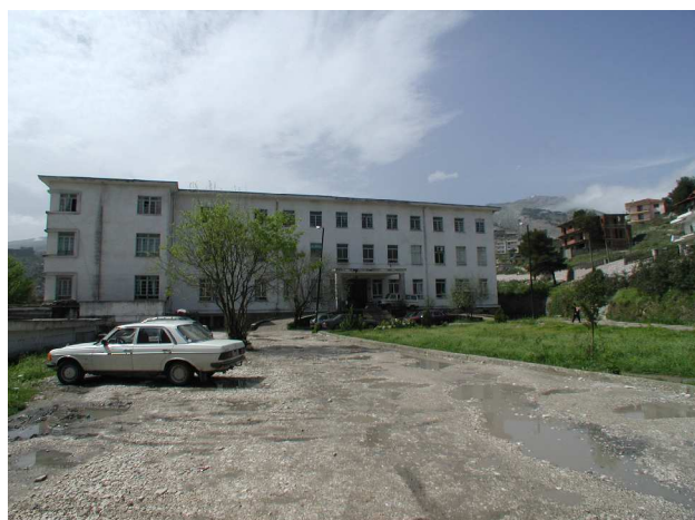
ギロカッスル地域病院外観
