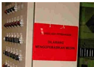
写真 5 修理中 SW 入れるな
