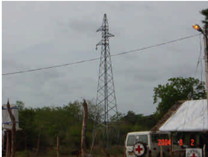
破壊された送電線
