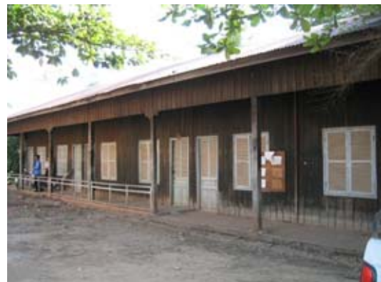
既存旧寄宿舍棟
