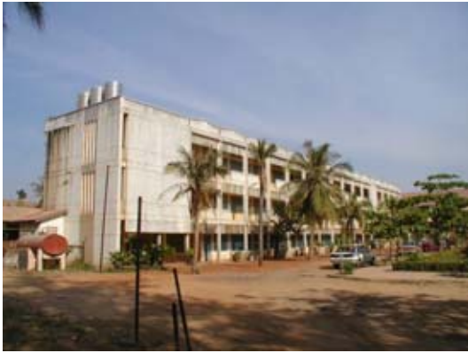
既存教室実習棟
