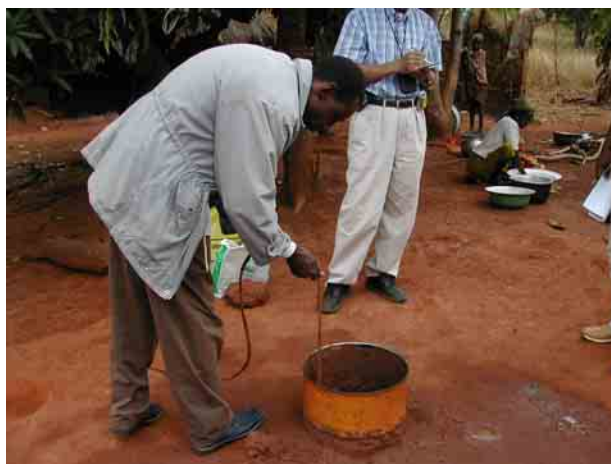
Djeria (No.52) 手掘り浅井戸(コンクリートリングなし)。深度 15m 以上。 乾季には枯れる。
