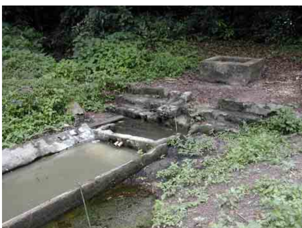
Nyep (No.72) 1960年代に湧水の取水設備を建設したが、失敗したまま放棄されている。
