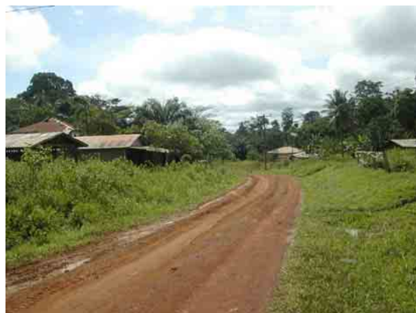
州内の主要都市を結ぶ幹線道路 (Ebolowa-Lolodorf)。雨天時の通行は非常に困難。
