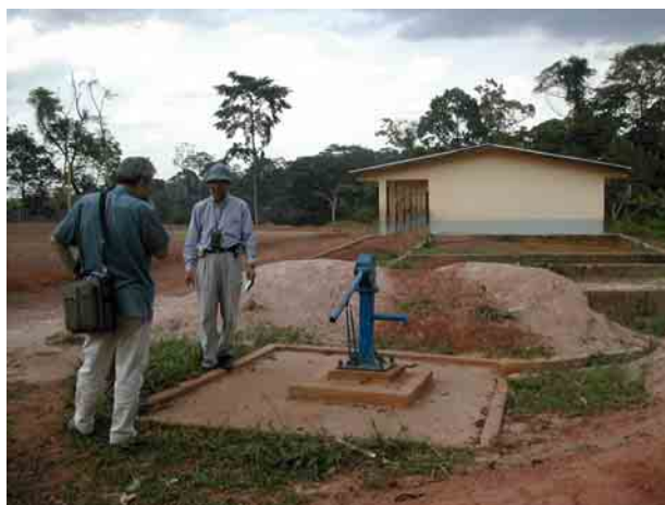
Afam-Oyo (No.66) 3年前にBIP予算で学校の敷地内に建設されたハンドポンプ付き浅井戸。水位低下のため、現在使用されていない。
