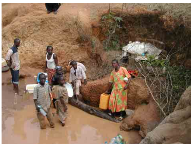
Gada Mabanga (No.50) ペリアーバンに位置する村落。湧水利用。水源保護のための 水路工事を実施中。
