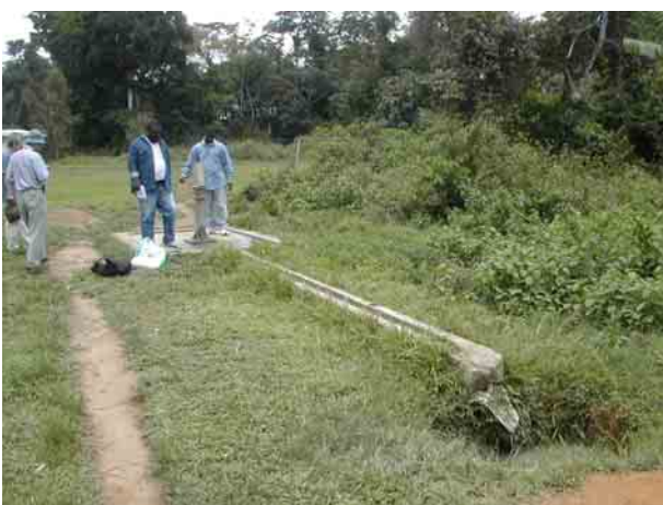
Ondong-Adjap (No.59) 学校の裏に建設されたハンドポンプ付き深井戸。排水路あり。乾季でも枯れない。
