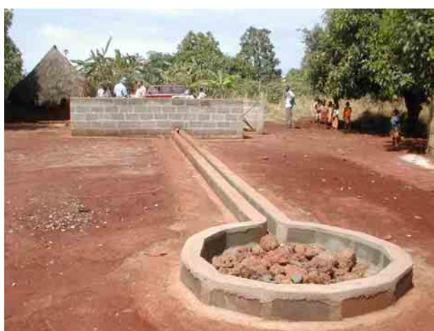
カナダ (ACDI) のプロジェクトサイト。水源保護のコン クリート柵と排水路が建設されている。ペルニエポンプ設 置予定。
