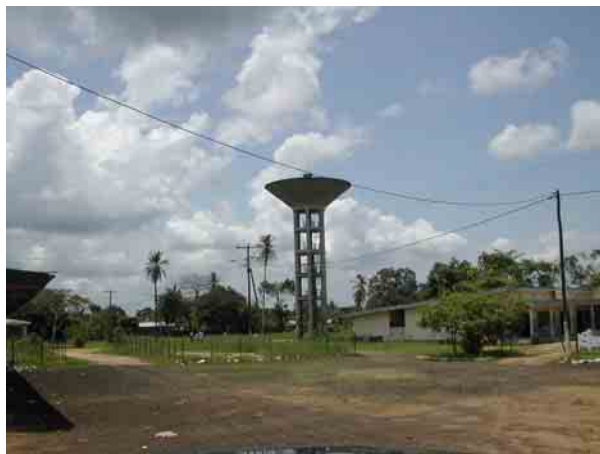
Dibombari (対象村落外) 無償資金協力「地方給水計画」(1994~96年度)にて建設した給水塔。
