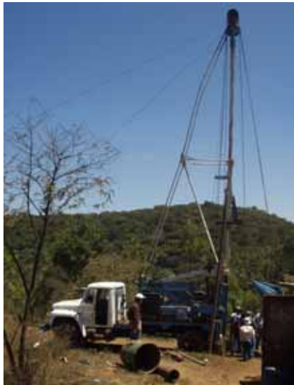
CHIMALTENANGO県EL SALT 稼働中のパーカッション式掘さく機(1号機)
