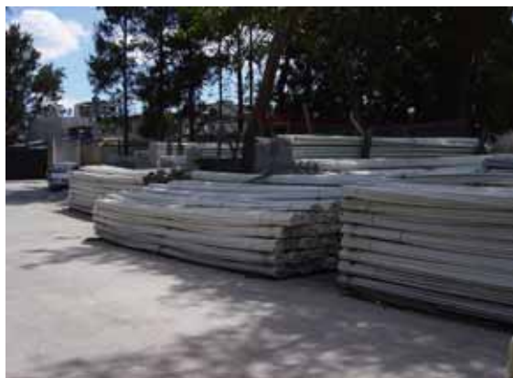
UNEPAR本部 地方給水施設建設用資材(配管用パイプ)
