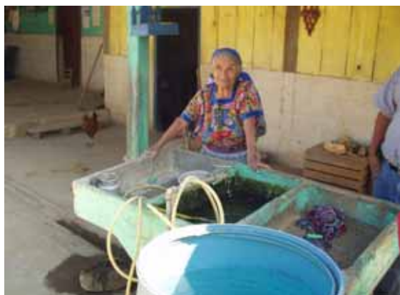
CHIMALTENANGO県 PANABAJAL 既存給水施設(給水栓と流し台)
