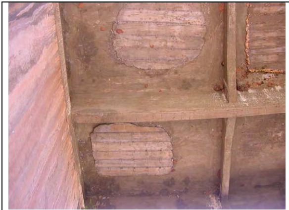
写真 2.1.5 側径間床版補修跡
