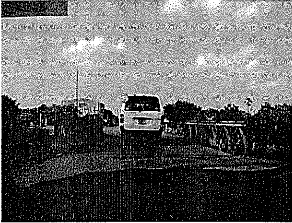
エレファントバスの入り口付近。ほとんどの橋が爆破されていて、鉄板を使って簡易の橋が架けてある。
