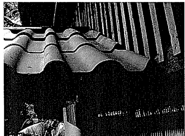
セメントで造った簡易屋根瓦。ジャフナ市内のレストランで、よく利用されていた。小規模ビジネスに利用できる。GTZも瓦製造の訓練を実施している。
