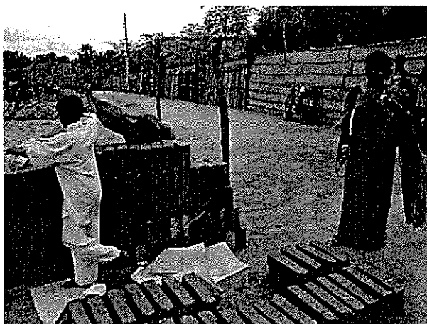
トイレ建設用のコンクリートの板。これを組み合わせて、トイレの主要部分が造れる。外壁とドアは各世帯が自費で建設する。
