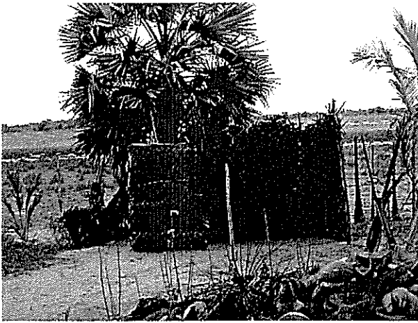
同村近くの家のトイレ。ココナッツの葉を編んだもので壁を造ってある。
