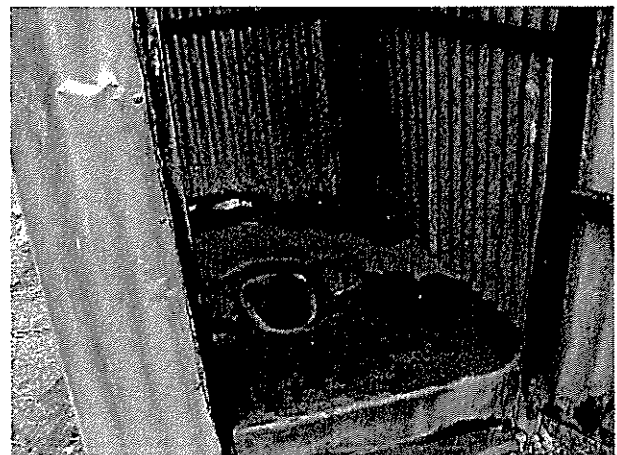
同避難センターのトイレ。回りがトタンで、バケツで水を流す水洗式。自然浄化式の浄化槽がある。
