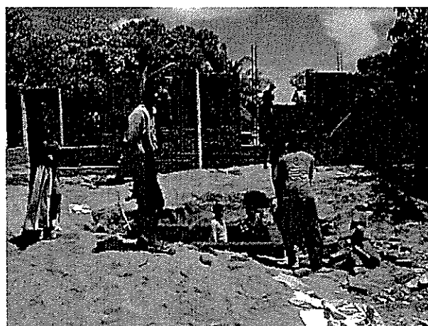
左官及び大工コースの実習訓練。トイレのセプティック・タンクを建設しているところ。
