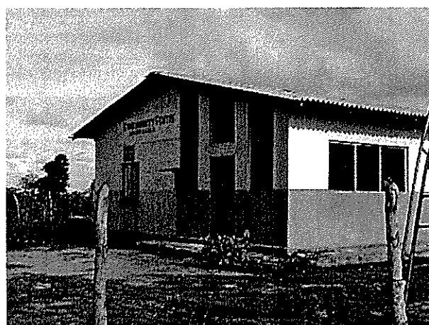
コミュニティーホールもUNICEFの支援で建設されたが、建設工事のほとんどは住民が行った。
