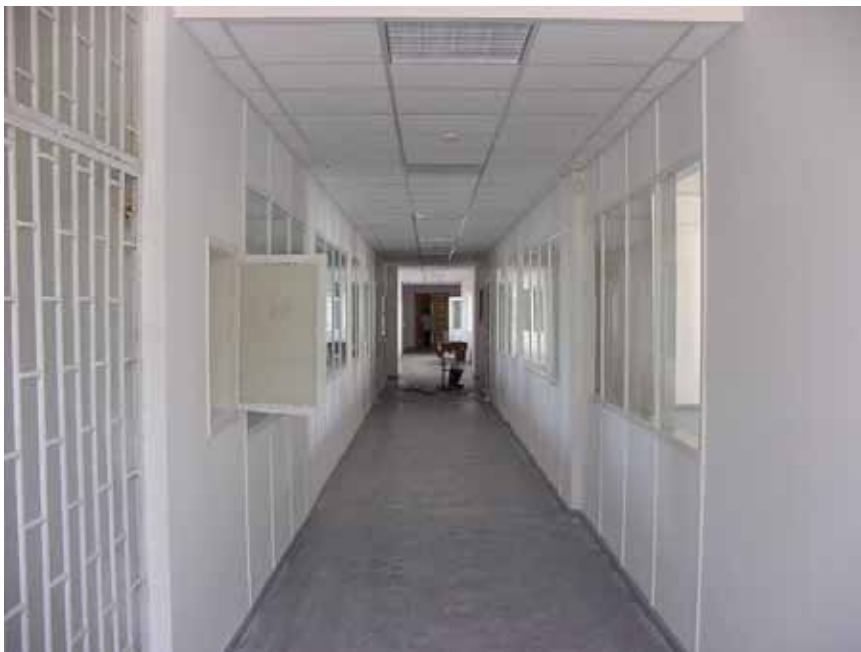
プロジェクト・サイト。各教室が面している廊下から撮影。2004年8月6日撮影
