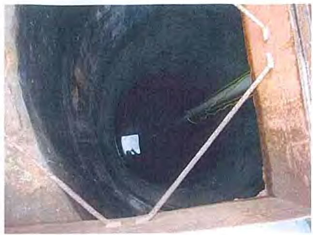
Wateraid が建設したハンドポンプつき Protected dug well。直径 2 m、深度 8 m。 最高水位 4 m (3 月)、最低水位 7.6 m (11 月) Kalolo TA Chiziko 村
