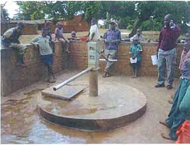
Wateraid が建設したハンドポンプつき Protected dug well。直径 2 m、深度 8 m。 最高水位 4 m (3 月)、最低水位 7.6 m (11 月) Kalolo TA Chiziko 村
