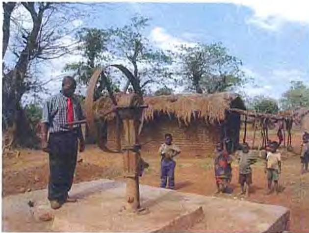
1970 年代に建設された同村内の井戸。2002 年にポンプリハビリが行われて一旦水が出たが、旧式のポンプ (GODWIN) で適切な部品が入手できなかったため、すぐに不調となって、放棄された。しかし、井戸そのものの再開発は一度も行われなかったにもかかわらず、30 年を経ても水が汲み上げ可能であるということは、地層が安定していて、井戸が長持ちすることを物語っている。
