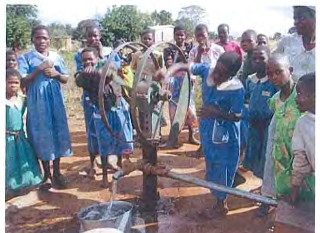
Khongoni 村 (Khongoni TA) 保健所近傍の井戸。スパウトに取り付けられたバルブを閉じると、手前のパイプを通じて保健所の高架貯水槽に水が揚げられる仕組みになっている。一見放棄井戸かと思われたが、ホイールを数十回回転させるうちに水が出てきた (右写真)。ポンプのシリンダーバルブ水漏れのため、揚水管内の水位が下がっていたことによる。
