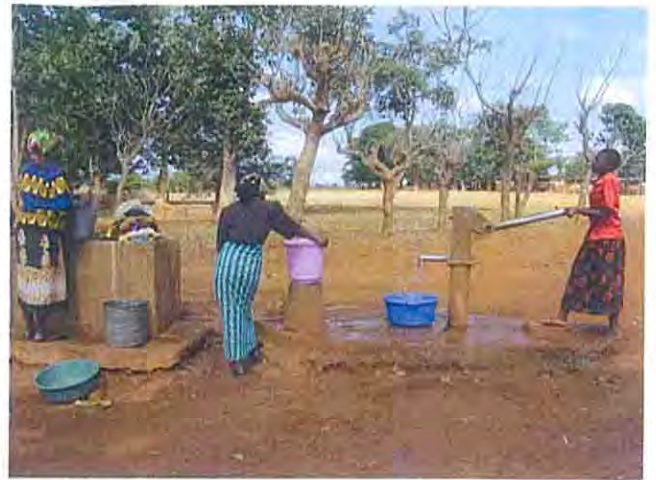
Chibungu 村 (Kalolo TA) 1980 年代に建設された小学校校庭のはずれの井戸。この Washing Basin は、民家が近いこともあってよく利用されている。現在、井戸付帯施設の国家設計基準となったものの原型。
