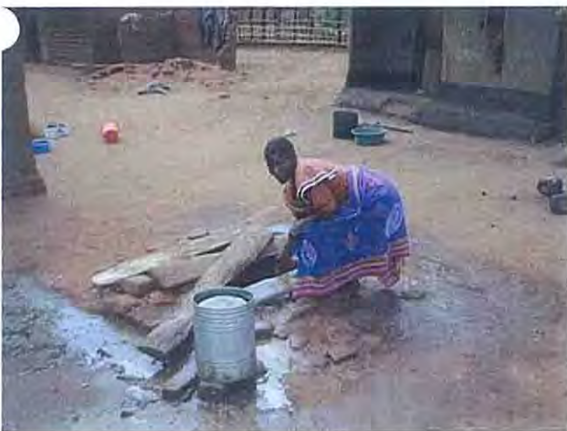
Kalolo TA Kalolo 村に 6 箇所ある Unprotected dug well の内 2 箇所 (上・下)。住民自身の手による開削。直径 80cm、深度 6 m。雨季乾季の水位差 3 m 程度。通年水位あり。基盤岩強風化による残留土 (ラテライト化している) であるが、片麻岩類の岩相を残しており安定自立の土壌である。
