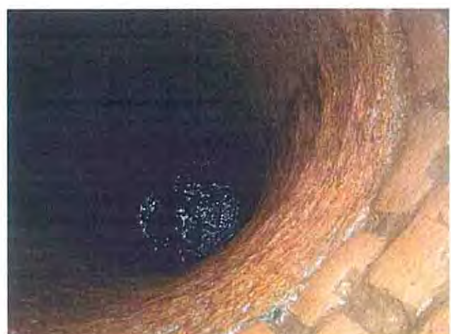
Kalolo TA Kalolo 村に 6 箇所ある Unprotected dug well の内 2 箇所 (上・下)。住民自身の手による開削。直径 80cm、深度 6 m。雨季乾季の水位差 3 m 程度。通年水位あり。基盤岩強風化による残留土 (ラテライト化している) であるが、片麻岩類の岩相を残しており安定自立の土壌である。
