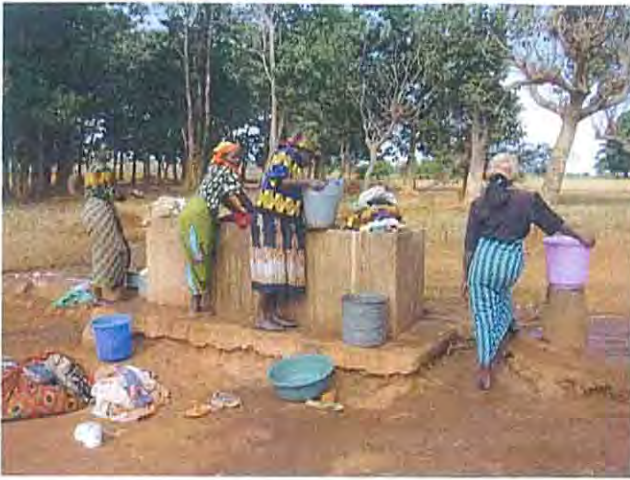
Chibungu 村 (Kalolo TA) 1980 年代に建設された小学校校庭のはずれの井戸。この Washing Basin は、民家が近いこともあってよく利用されている。現在、井戸付帯施設の国家設計基準となったものの原型。
