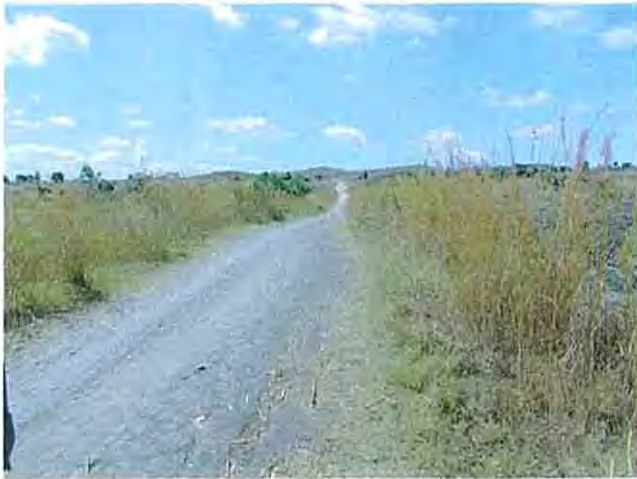
対象地域内の典型的なアクセス道路。未舗装であり乾期の通行は問題ないものの、雨期には泥濘化する。
