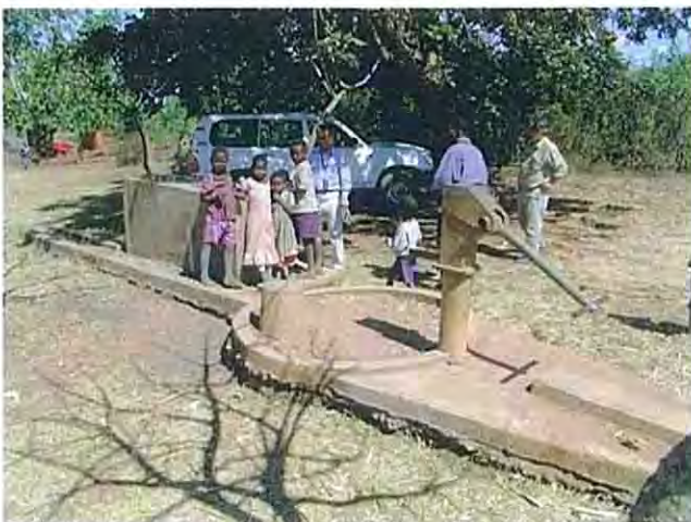
対象地域の故障したハンドポンプ（コンゴニ郡カサンダ村）。2001年に故障。修理費用を集めようと努力しているが不十分。
