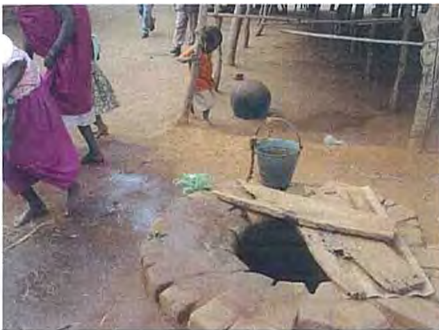
Kalolo TA Kalolo 村に 6 箇所ある Unprotected dug well の内 2 箇所 (上・下)。住民自身の手による開削。直径 80cm、深度 6 m。雨季乾季の水位差 3 m 程度。通年水位あり。基盤岩強風化による残留土 (ラテライト化している) であるが、片麻岩類の岩相を残しており安定自立の土壌である。
