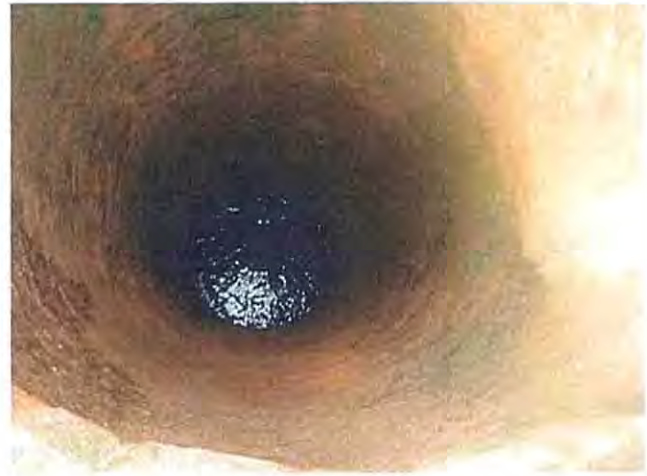
Kalolo TA Kalolo 村に 6 箇所ある Unprotected dug well の内 2 箇所 (上・下)。住民自身の手による開削。直径 80cm、深度 6 m。雨季乾季の水位差 3 m 程度。通年水位あり。基盤岩強風化による残留土 (ラテライト化している) であるが、片麻岩類の岩相を残しており安定自立の土壌である。
