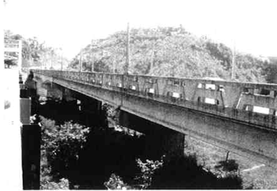
北行き車線 (PCゲルバー桁を有するPC)
