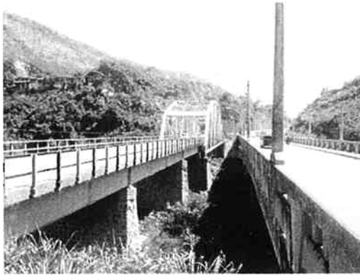
行き車線 (鋼トラス、1943年完成)
