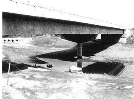
橋脚の状況。(右が下流側)
