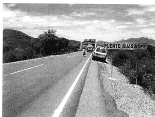
橋梁周辺状況 (ニカラグア方向を望む)
