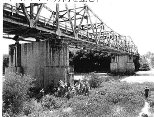
橋梁と主流路上の橋脚 (他の3橋と比較して川が大きい) (右が下流側)
