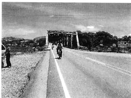
橋梁周辺状況 (エルサルバドル方向を望む)
