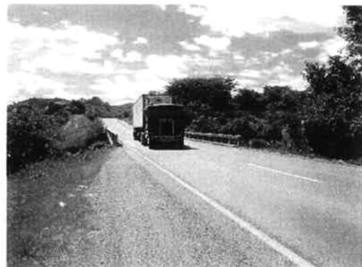
橋梁周辺には人家がまったく存在しない (エルサルバドル方向を望む)
