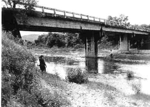
ナマングエ川流路上に橋脚はない (左が下流側)
