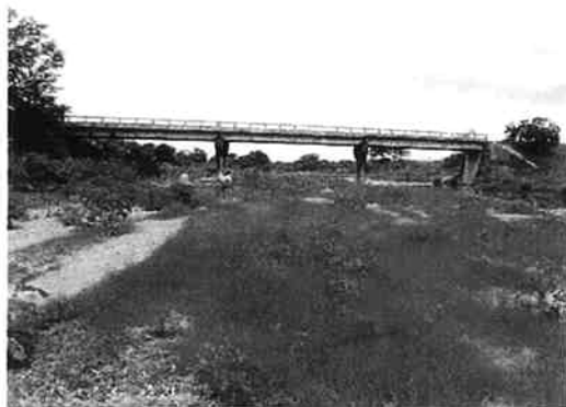
橋梁全景。河川敷は草地となっている (上流から橋を望む)
