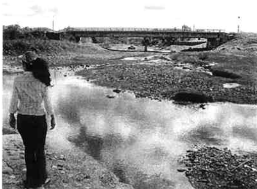
橋梁全景(上流側仮設道路上より)。無降雨時は流れが少なく淀んでいて水質悪い
