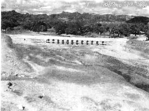
1997年架け替え時の上流側仮設道路。住民の要望で撤去されなかった。
