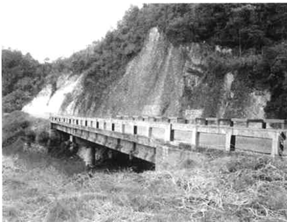
洪水により決壊した道路を橋に架け替えた例
