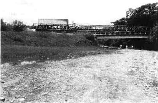
左側の旧橋取り付け盛土がササカレ川河積を半分以下に狭めている(上流側より)
