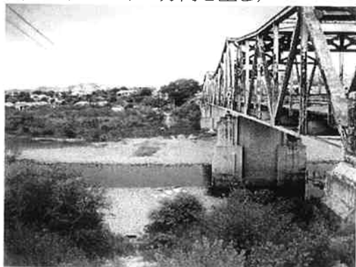
橋梁の下流右岸に民家が点在 (左が下流側)
