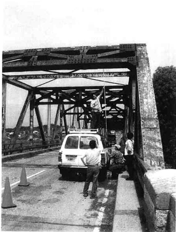
実際の建築限界の測定
