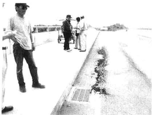
常温混合アスファルトの使用によって劣化した舗装面
