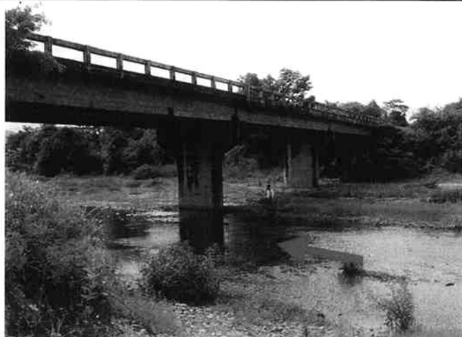
② ナマシグエ橋：(エル・サルバドル方を望む) 3径間単純PCI桁橋、橋長 69m
