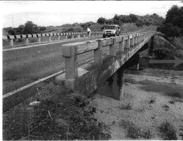
② ナマシグエ橋：(ニカラグア方を望む) 取り付け道路は一直線となっている。
