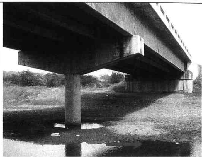
④ アグア・カリエンテ橋 (ニカラグア方を望む) 中央橋脚の径 (1.0 m) が小さく、直接基礎も浅く、 小さ過ぎる。
