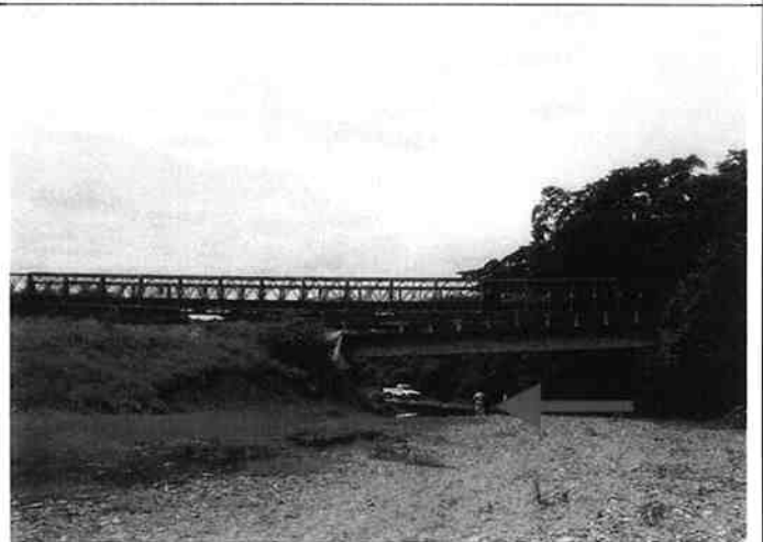
③ ラス・オルミガス橋：(左がニカラグア方) 仮設橋 (ベアリー・ブリッジ) が架かっている。
