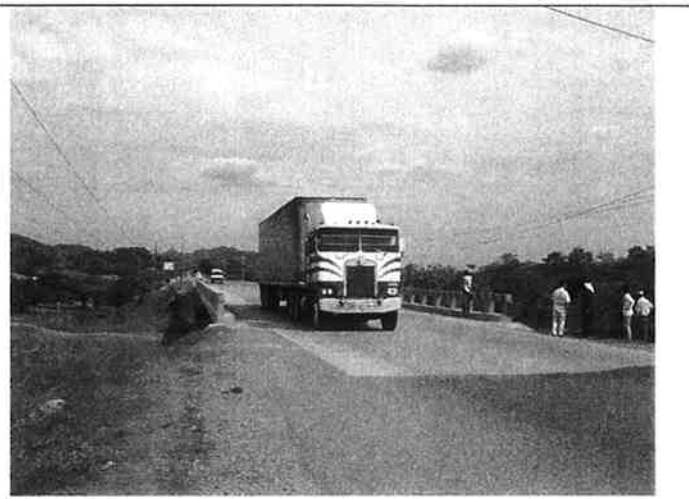
④ アグア・カリエンテ橋 (ニカラグア方を望む) 大型車が走行すると揺れが大きい。
