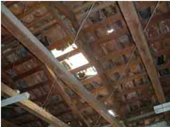
教室内部から見上げた屋根
