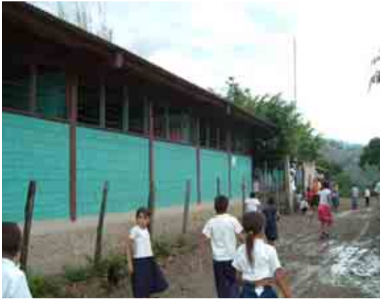
校舎外観と前面道路
