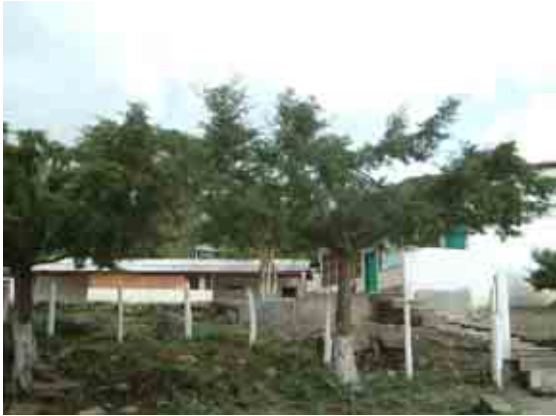
前面道路よりの校舎外観
