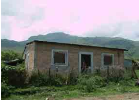
前面道路よりの校舎(民家)外観
