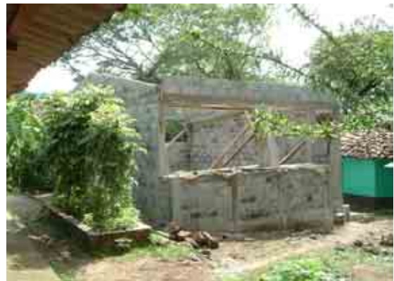
建設中の教室
