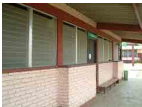
教室棟のガラスルーバー窓
