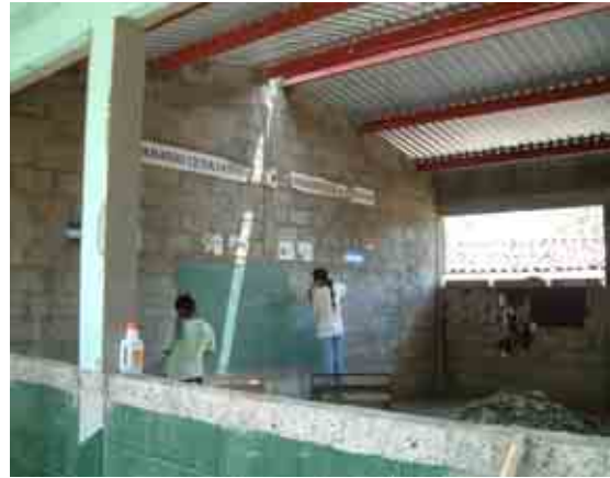
改修工事中の教室
