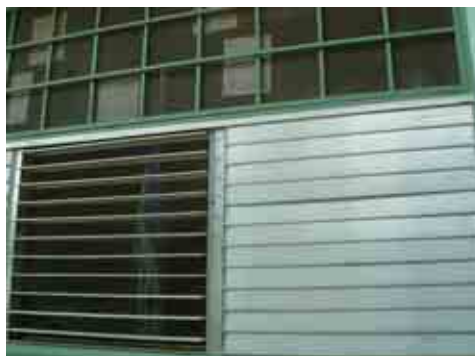
アルミルーバー窓の開閉状態
