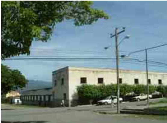
前面道路よりの校舎外観
