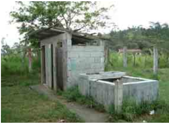
トイレ及び給水施設外観
