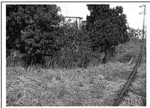
ALCANTARILLA EN EL TRAZADO DEL TRAMO 1 INICIO DEL ESTUDIO CALLE C Y LINEA DE FERROCARRIL
