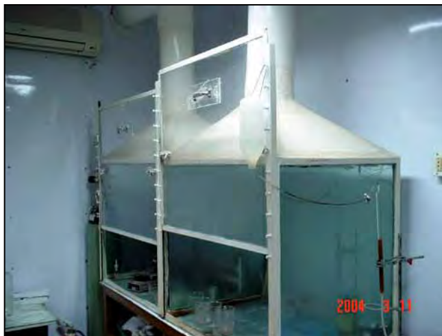
写真 分析室のドラフトチャンバー
