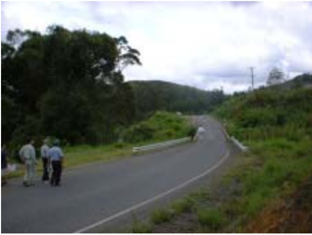
ゴロカ側より見た橋面及び取付道路の現況。
