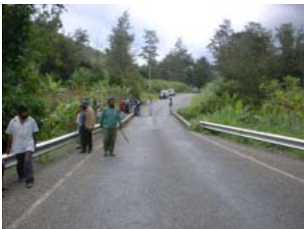
レイ側より見た橋面及び取付道路の現況。
