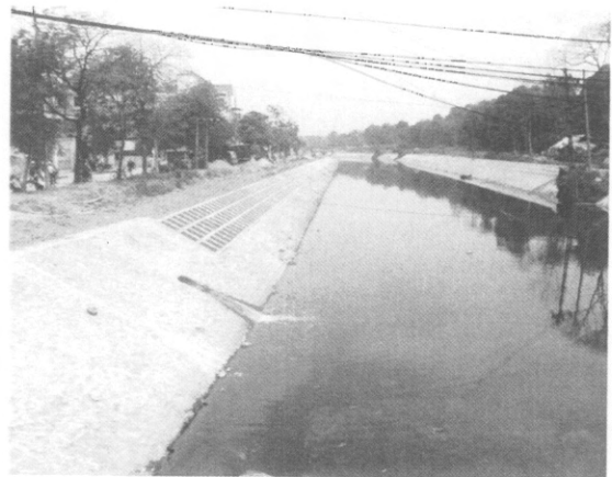
ToLich 川の状況。下水・排水路として利用されており、水は黒く悪臭を放っている。
