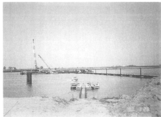
環状3号線の延伸として紅河にかかる新設道路橋で、JBICの融資によって日本のゼネコンが建設中である。
