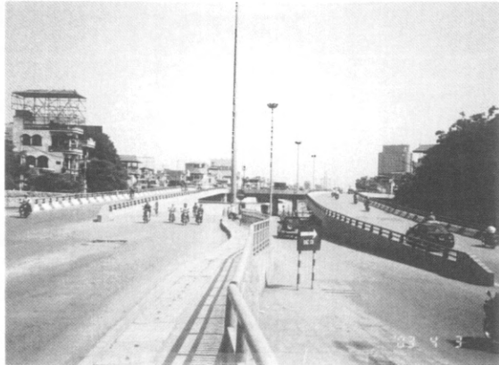
Chuong Duong 橋付近にある市内では珍しい立体交叉道路
