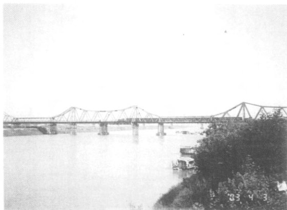
1902年フランスが建設したLong Bien 鉄道橋。老朽化が進み、列車は15 km以下に制限されて運転している。
