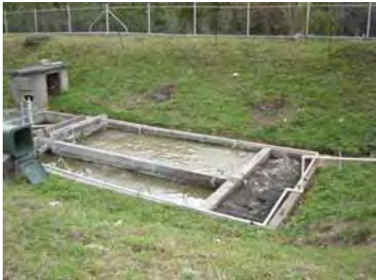
汚水処理槽：開放型のため臭気、汚染の危険性がある。 汚水処理水の浸透、蒸発池
