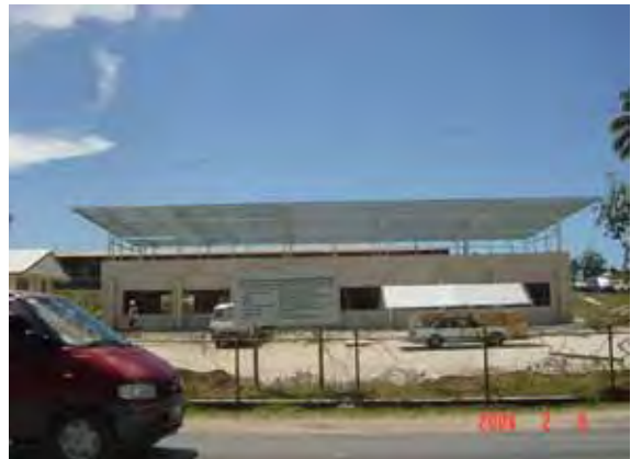
建設中の保健省庁舎 (AusAID 援助)
