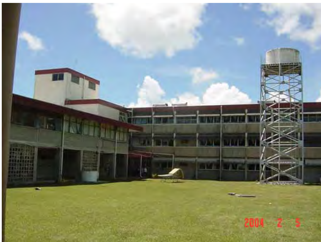
建設予定地：東側より敷地を望む。正面3階建て病棟、左側1階：産科病棟、2階：手術室
