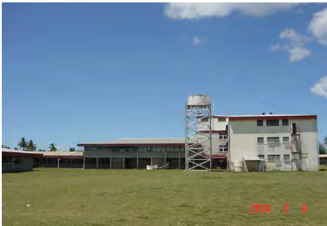
建設予定地：南側より敷地を望む。右側 - 3階建て病棟、中央2階建て1階：産科病棟、2階：手術室、 左側 - 糖尿病クリニック
