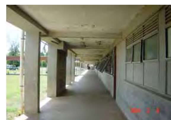
産科病棟・分娩部前の渡り廊下(左側：CSB 建設地)
