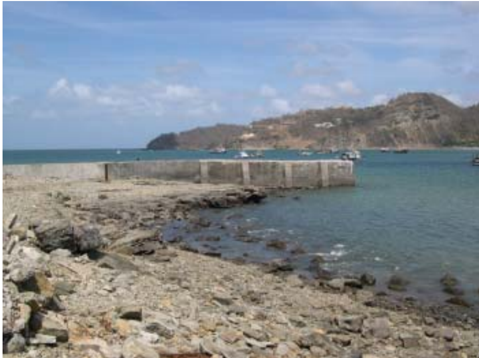
海岸状況（埋め立て予定地から既存防波堤を望む）
