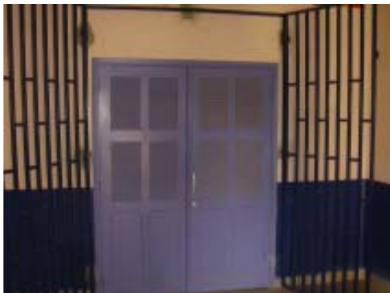
コンピュータールーム入口
