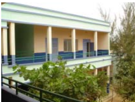
校舎 2F、片側全景
