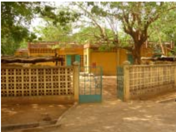
建屋入口付近
