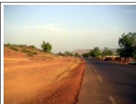
④AE カチの全面道路を、バマコ方面（②とは逆方向）に眺めた写真。国道の路面状態は良好。
