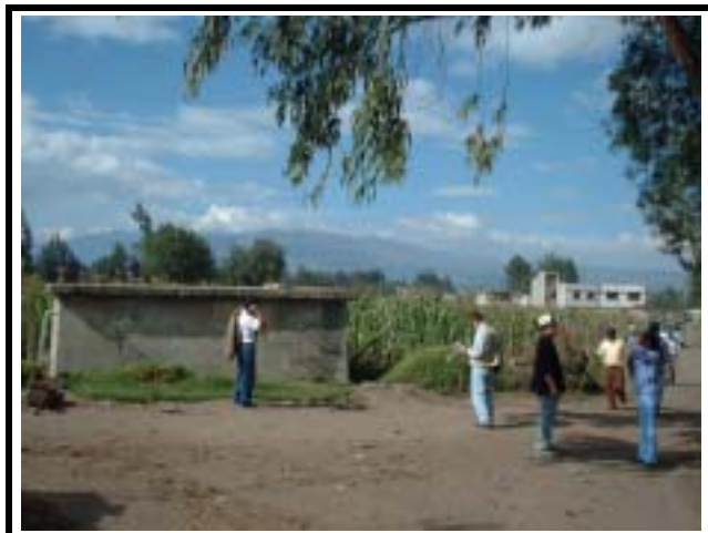
ヤルキエス (No.4) 既存配水池
