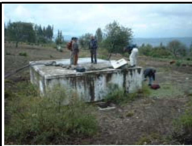
ロスチンガソ (No.14) 既存配水池
