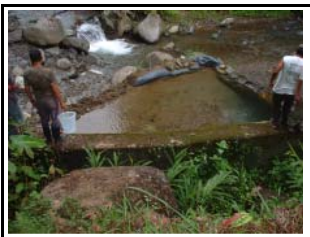
ブエノスアイレス (No.7) 溪流取水地点。雨期には濁度が上昇するため取水は停止される。
